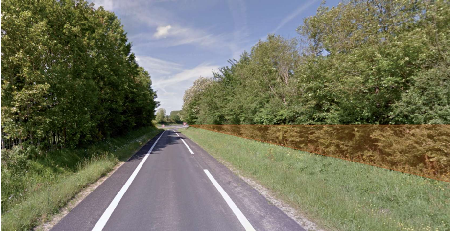
Vue rapprochée 5 : Vue depuis la bretelle d'accès à l'autoroute A20.
